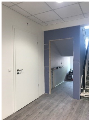
Stauraum am Treppenaufgang, Tür zum behindertengerechten WC
