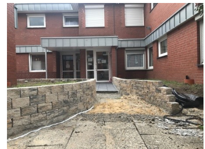
Erste Formen werden im Außenbereich sichtbar
