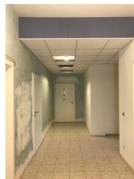
Zwischendecke im 2. Bauabschnitt mit Saal und Büros
